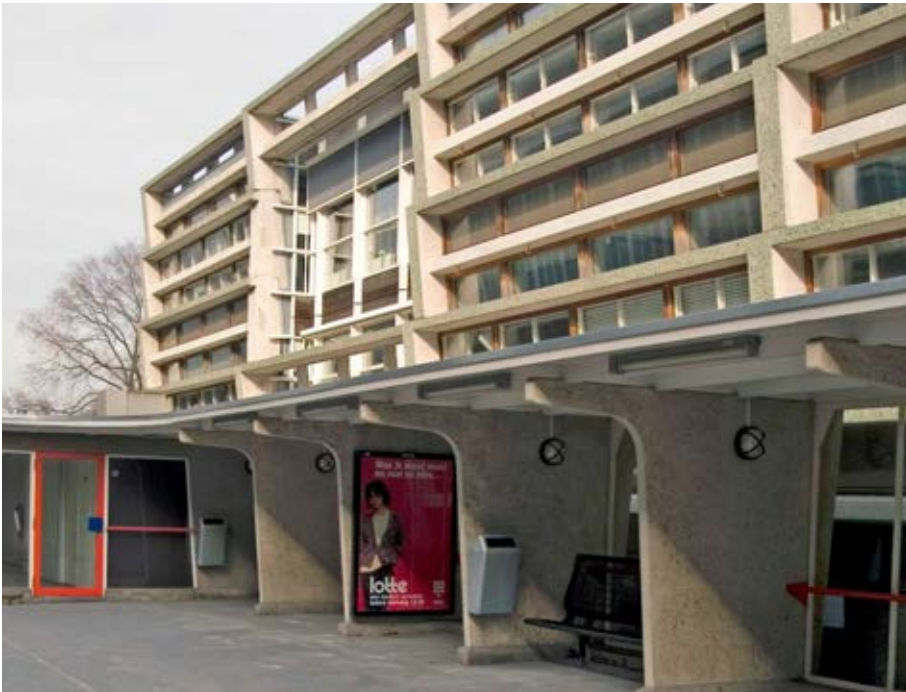
Figuur 7 Aanzicht Noordgevel vanaf het stationsperron
